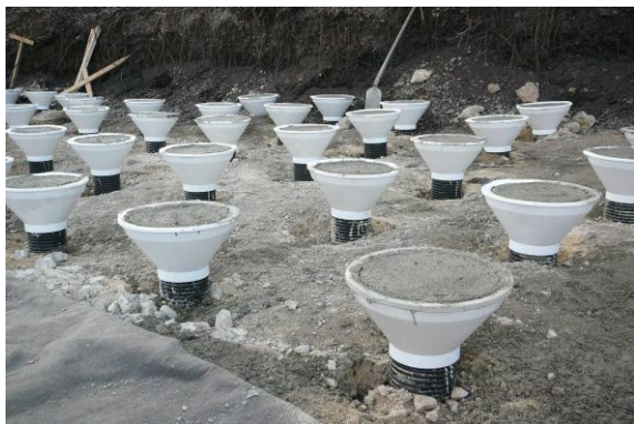
Obr. 3: Nainštalované mikropilóty vyplnené betónom
