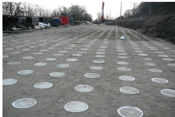
Obr. 4: Priestor medzi mikropilótami vyplnený jemnozrnným materiálom
