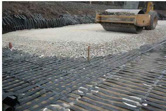
Obr. 6: Budovanie vankúša zo štrkodrvy
