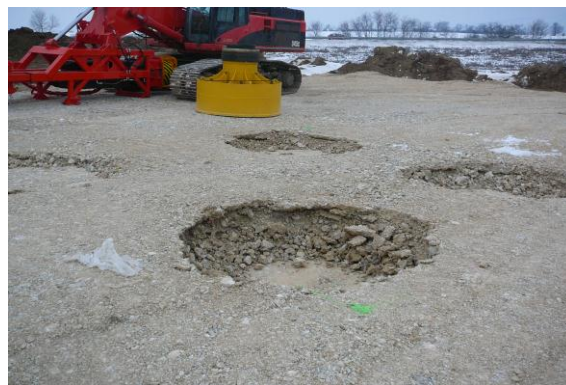
Obr. 8: Skúšobné pole pre dynamické hutnenie
