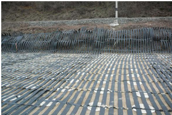
Obr. 5: Vysokopevnostné geomreže položené na hlavách mikropilót
